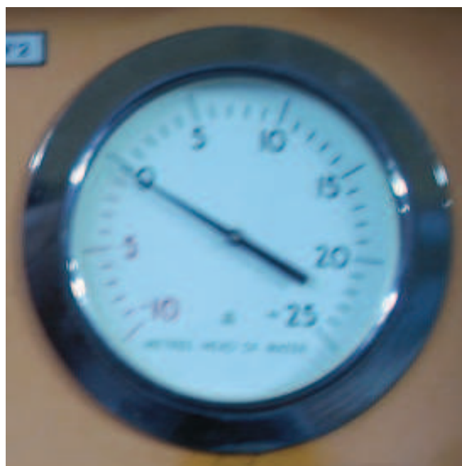
شکل ۱۲.۱۰: به جهت نشان دادن فشار در هریک از مقاطع انتهایی پمپ از فشارسنج‌های بُردن استفاده می‌شود.
